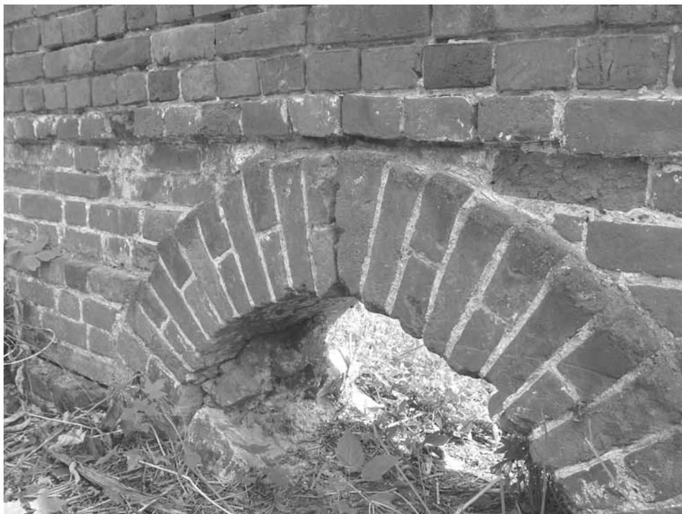
Рис.6 Дренажное отверстие северной стены.
