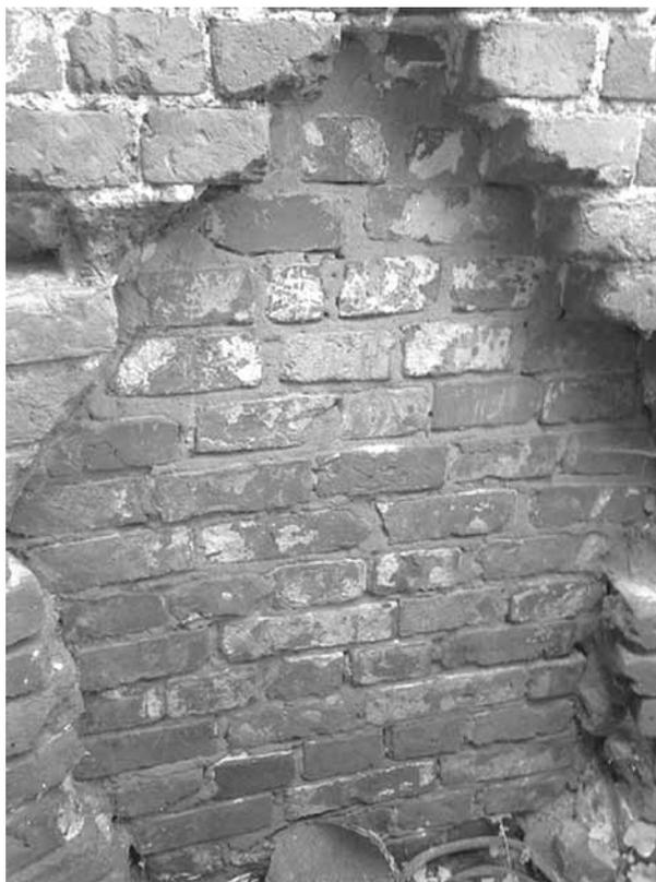
Рис.9 Заложенный пролом
